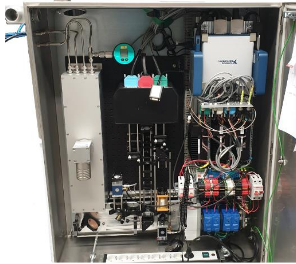
QCL-Sensorplattform; installiert in einem Industrierack. (© CHASE/Moser)
